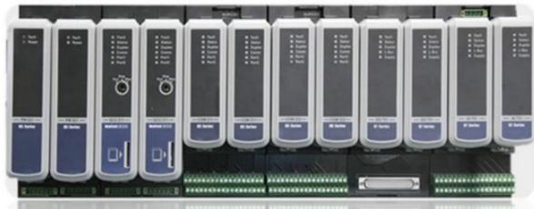
冗余电源 冗余控制器 I/O模块和通讯模块
